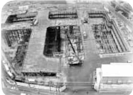
工事が進む元町北地区再開発事業
