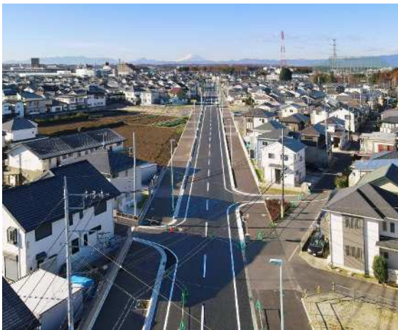
北野下富線(3工区開通)
