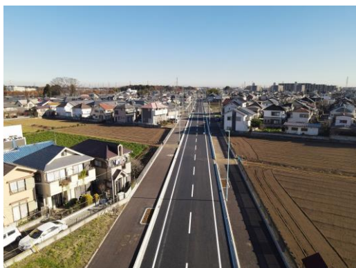
幹線道路の建設 都市計画道路 北野下富線
