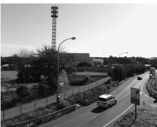
▲関越道所沢インターチェンジ付近
