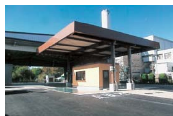
市民持込みステーション
