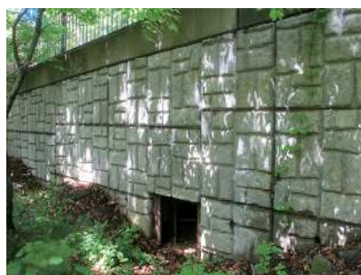
生きもののためのトンネル (東京狭山線)
