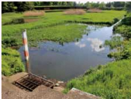
砂川堀北野調整池（ビオトープ）
