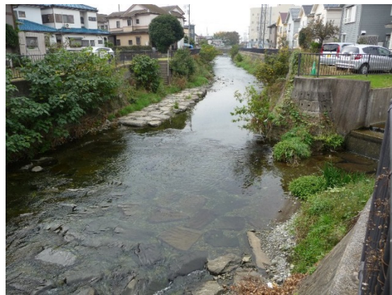
河床には礫や土砂が堆積している
