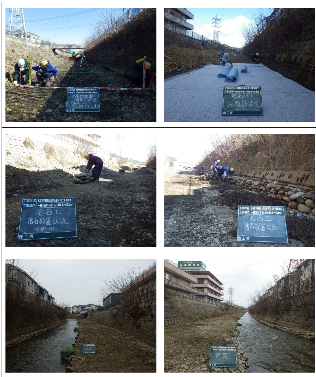
図 5.3 工事中および竣工時の状況
