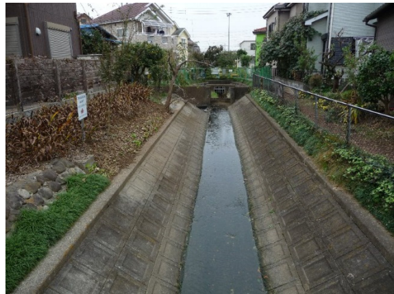
水量が少ない時は、水は上林川方面に左折し、林川（直進）には流れない
