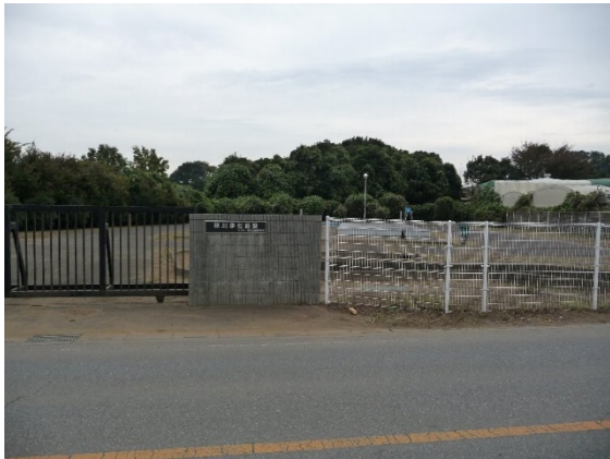
④林川浄化施設
