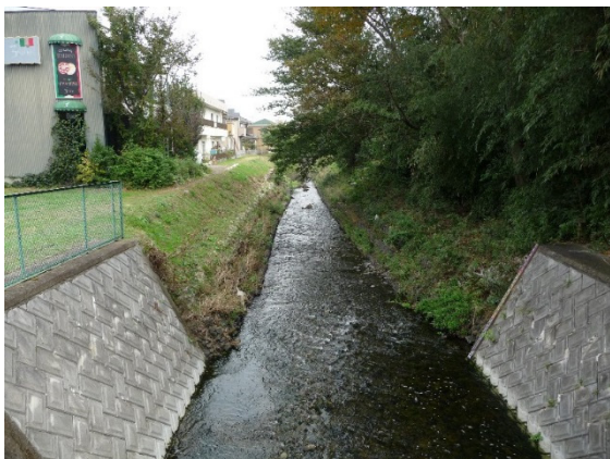
多自然型護岸に改修されている
