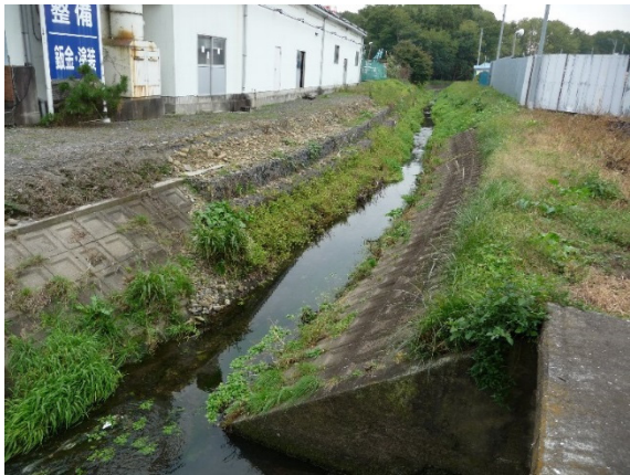
部分的に多自然型護岸に改修されている
