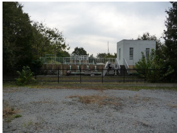
久保川浄化施設
