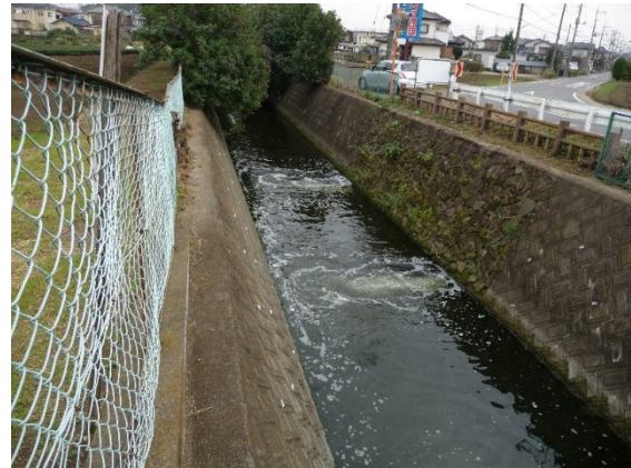
還流水が供給されている
