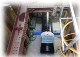
大口径管推進工事
