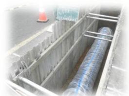
大口径管更新工事
