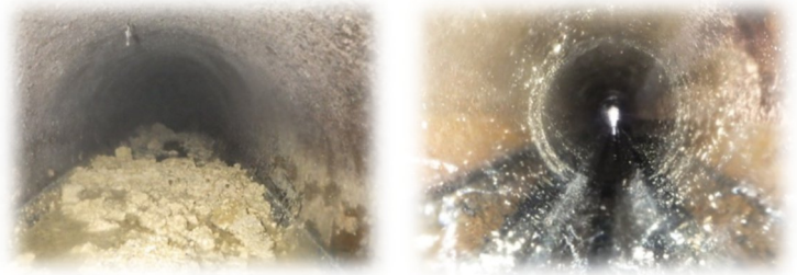
下水道管渠清掃業務（左：清掃前 右：清掃後）
