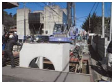
マンホール耐震工事の様子
