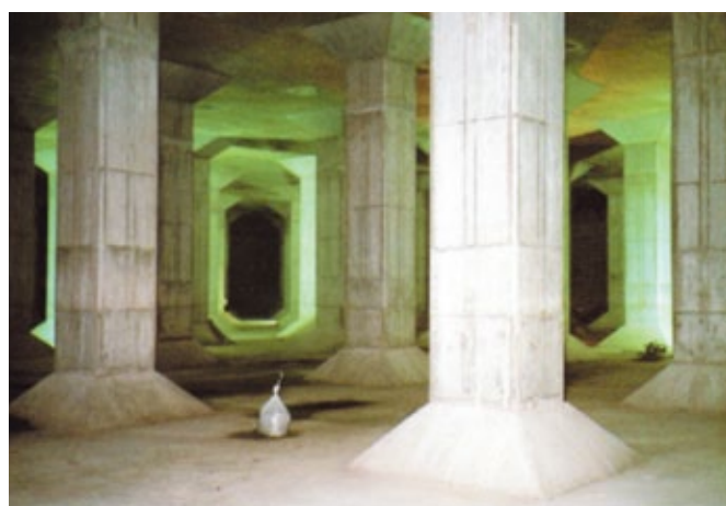
雨水調整池の中の様子
