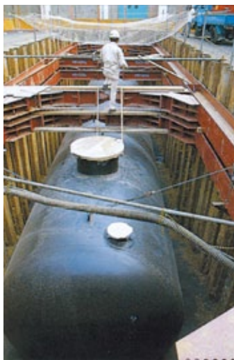
耐震性貯水槽の工事の様子
