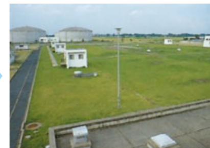
⑤浄水池 きれいに処理された水をたくわえる。
