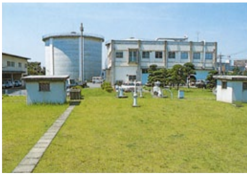
第一浄水場 宮本町二丁目7番7号
