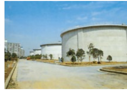
④配水池 飲めるように処理された水をためておく。
