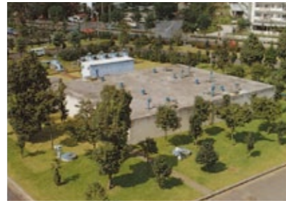
②着水井 地下水を受け入れ、水の量を計測し、消毒剤で滅菌する。
