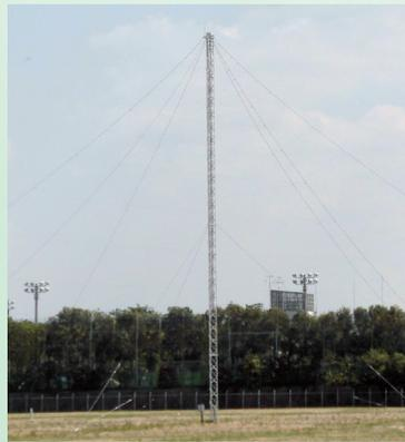
**コニカルモノポールアンテナ**：近中距離用無指向性のアンテナ。2 基
